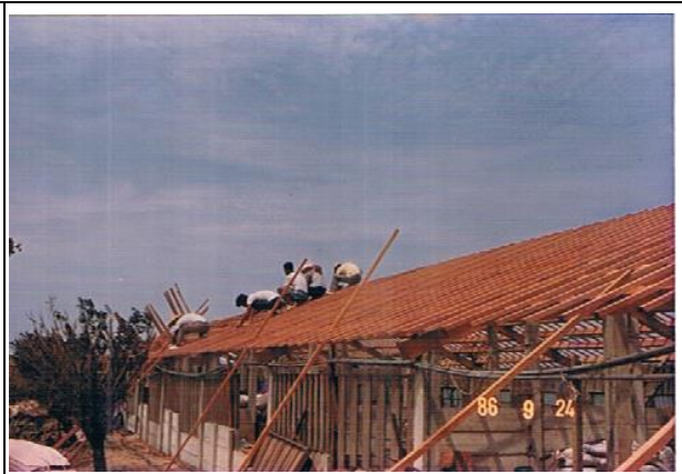
75年的韋恩颱風後受災鴨寮重建
