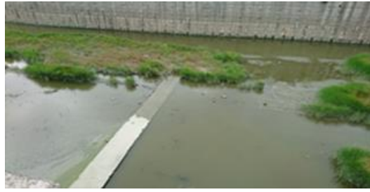
圖 2-22 正常使用中埤的河道
