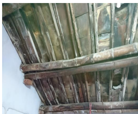
圖 4-2 古厝竹製的屋頂結構
