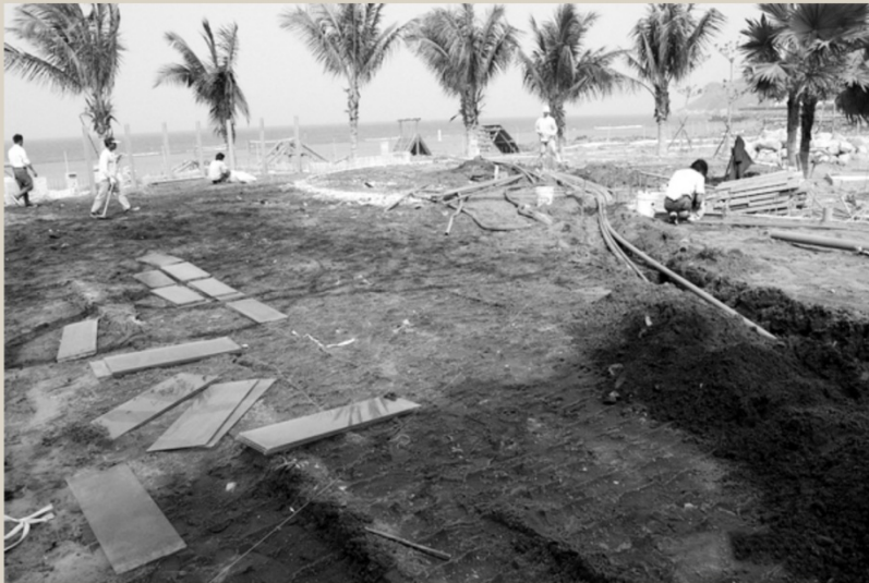
西子灣 沙灘景觀整修中 2002年
